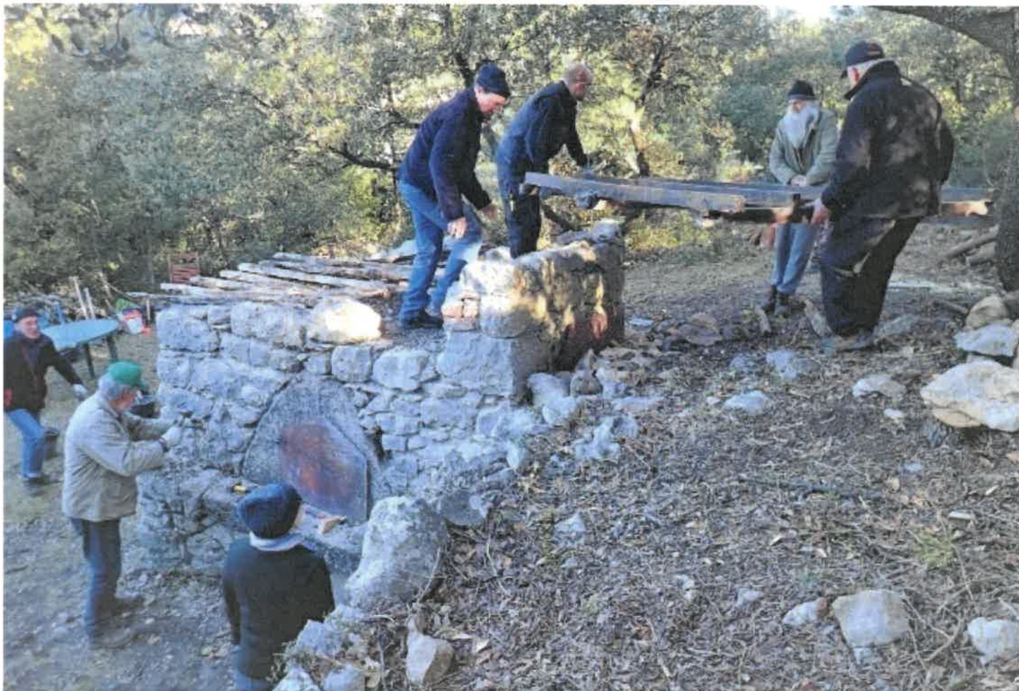
Dépose du toit, grattage des joints
