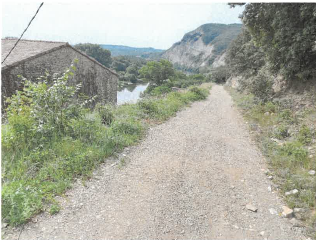
Réfection de l'empierrement du Chemin du Moulin endommagé lors des orages
