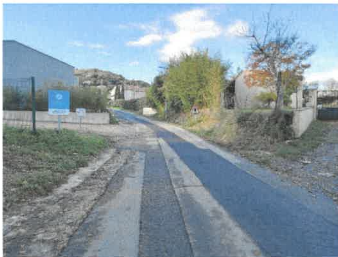
La D161, avant travaux
