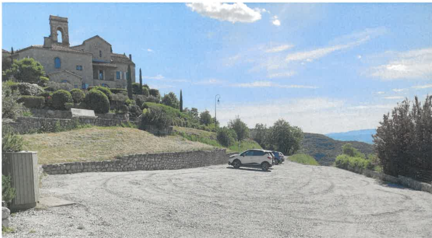
Travaux de maintenance de l'empierrement du parking de l'église
