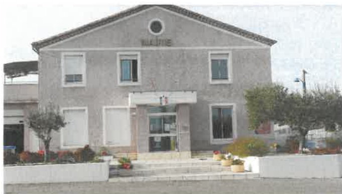
Façade de la mairie avant travaux
