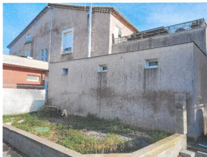
Avant travaux de sécurisation de la citerne gaz
