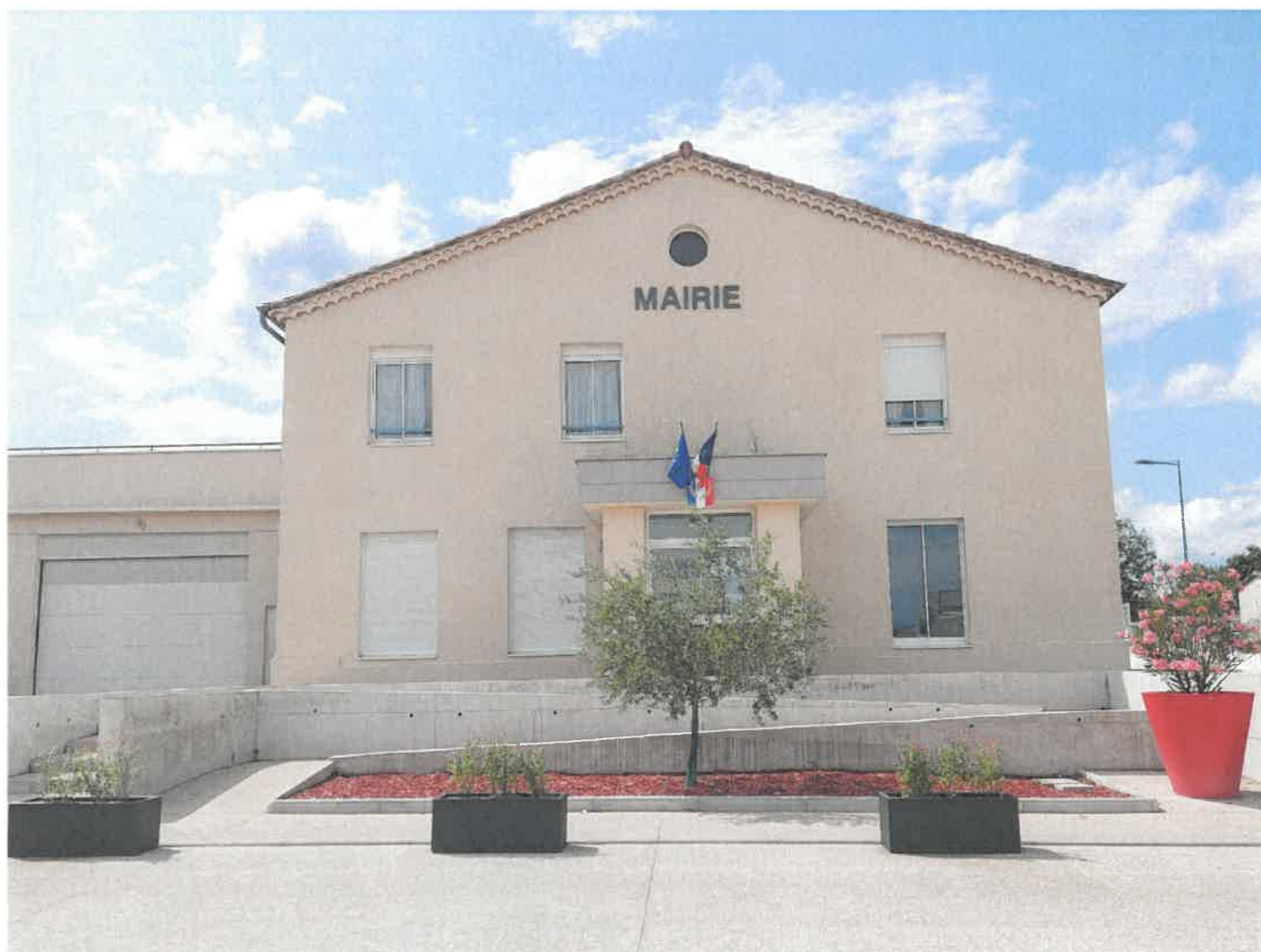
Après rénovation de la façade
