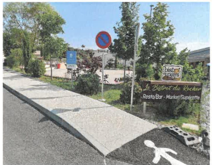
La route du Rocher après les travaux d'aménagement entre le pont et la mairie
