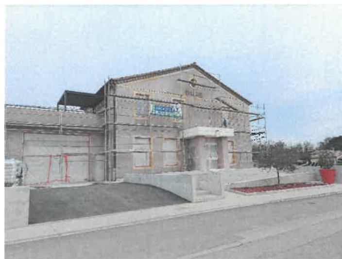
Travaux de ravalement des façades de la mairie
