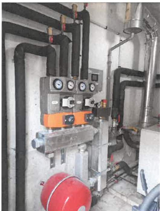
Branchement de la mairie au réseau de chaleur
