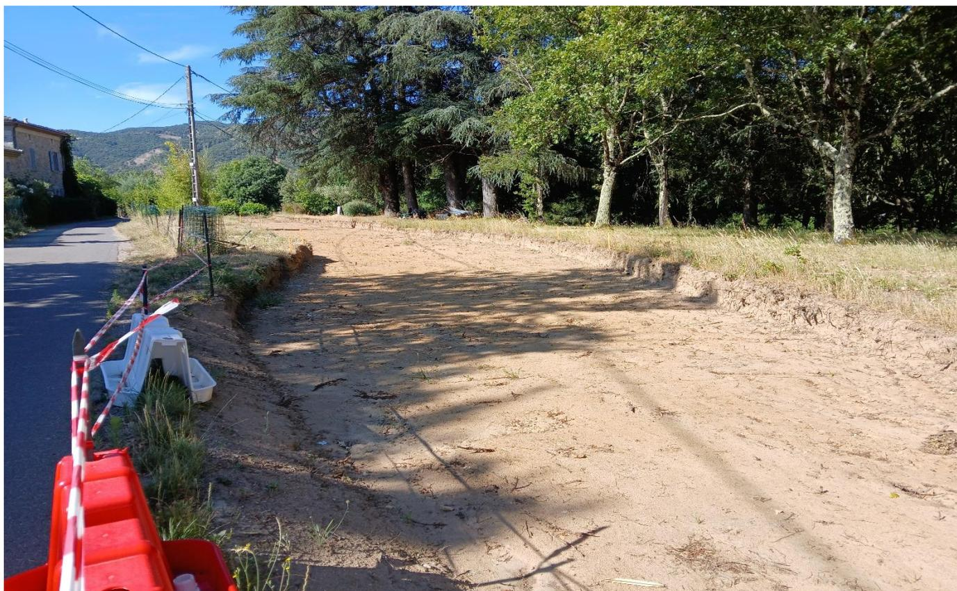
Déplacement et élargissement du **Chemin des Vignes** : Terrassement de la nouvelle emprise avant enfouissement de l'eau potable, des réseaux d'électricité et de fibre optique à partir de septembre prochain.
