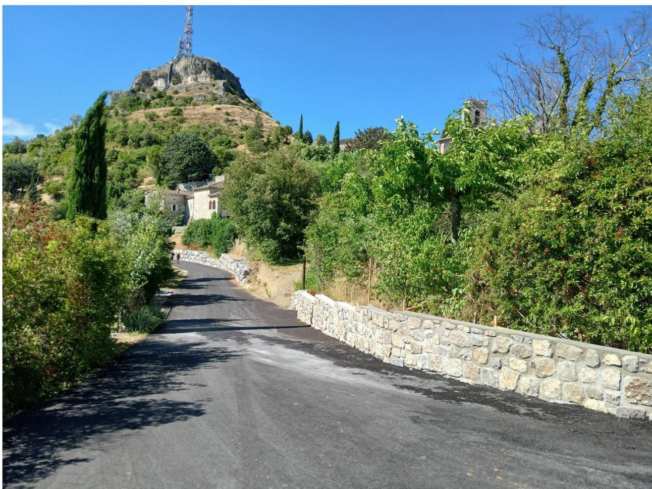
*Après les travaux d'élargissement, de construction d'un enrochement et d'un muret, de goudronnage et de plantation sur les accotements*
