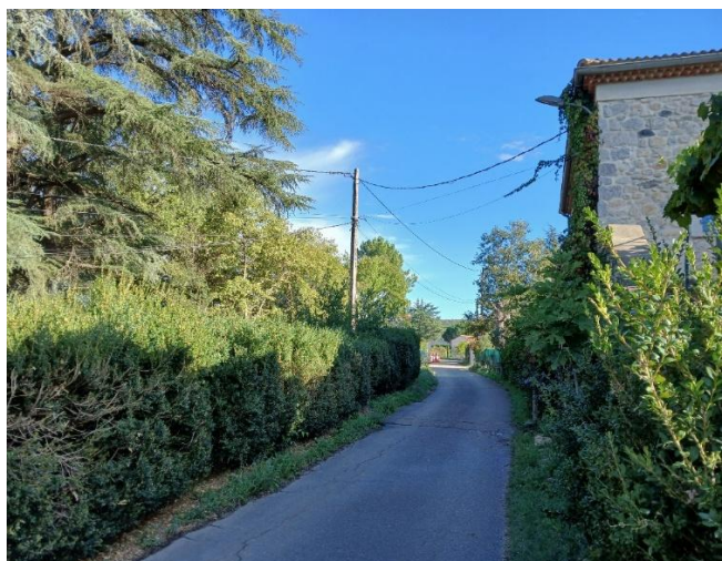
Avant travaux et la création de la nouvelle chaussée
